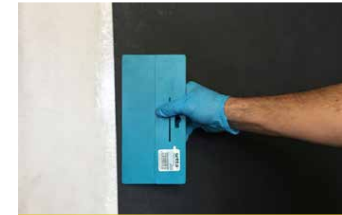
3. Auflegen des Heizvlieses und ausstreichen der Blasen
