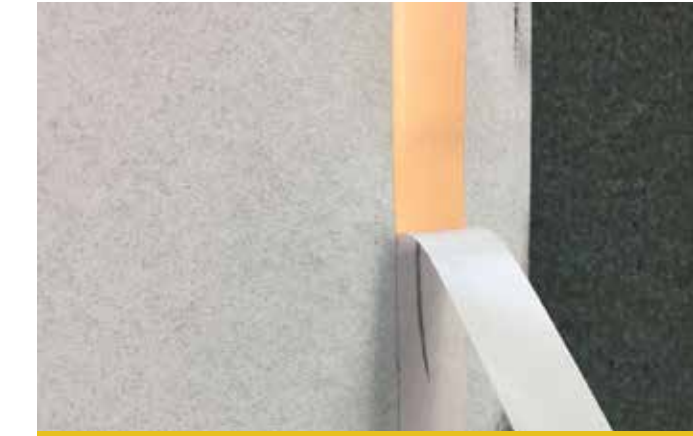
1. Abziehen der Schutzfolie auf Elektroden im Bereich des Heizvlieses
